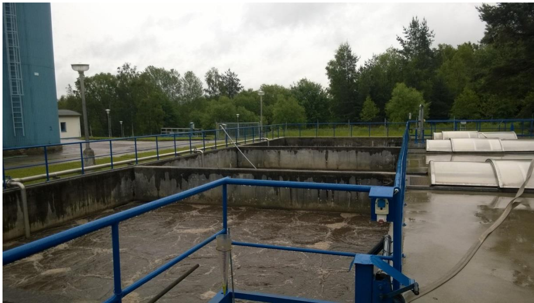
OBRÁZEK 11 : NITRIFIKANÍ NÁDRŽE LEVÉ TECHNOLOGICKÉ LINKY
