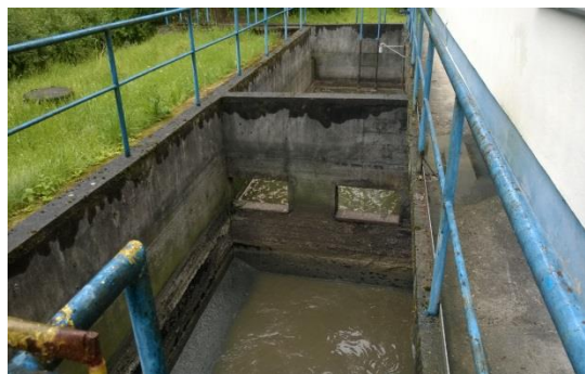
OBRÁZEK 7 : DVOUKOMOROVÁ ČERPAČÍ STANICE ODPADNÍCH VOD S PŘEPADEM DO ŘEKY
