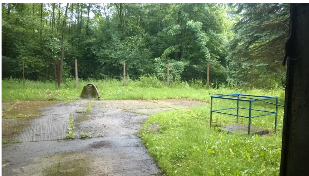
OBRÁZEK 3 : VYPÍNACÍ ŠACHTA PŘED ČOV
