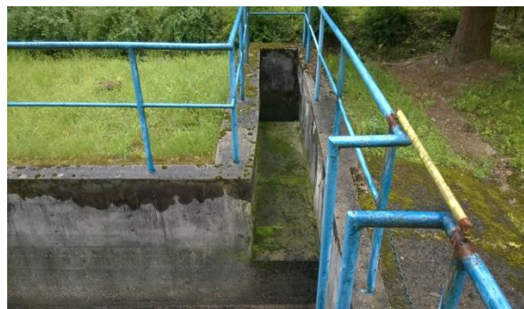
OBRÁZEK 7 : DVOUKOMOROVÁ ČERPAČÍ STANICE ODPADNÍCH VOD S PŘEPADEM DO ŘEKY
