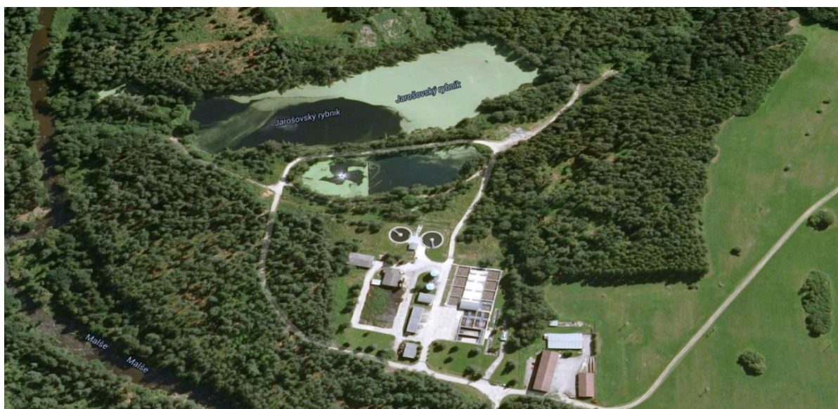
OBRÁZEK 1 : ČOV KAPLICE - CELKOVÝ POHLED
