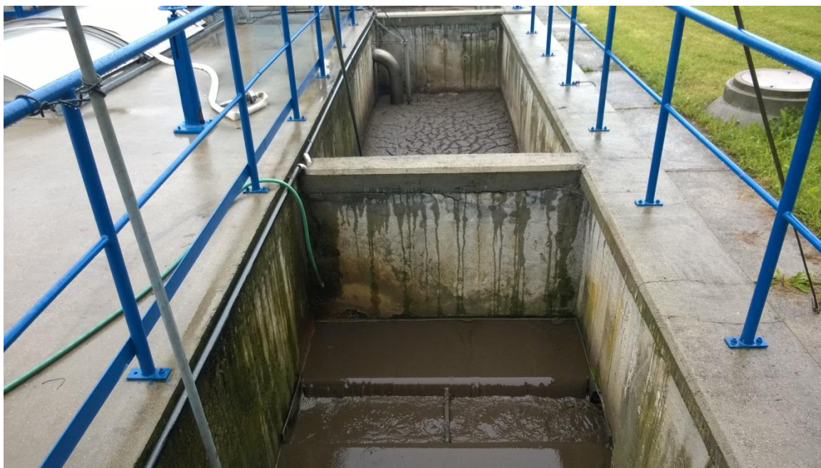
OBRÁZEK 12 : ODPLYŇOVACÍ ZONY A DÁVKOVÁNÍ KOAGULANTU
